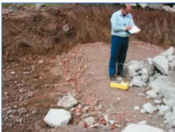
Fig 30: Aplicación de áridos reciclados Tipo 4 en relleno de solares.
