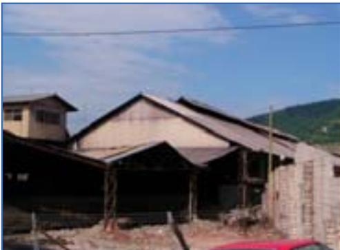
Fig 2: Edificio industrial de estructura y cerramiento metálico.
