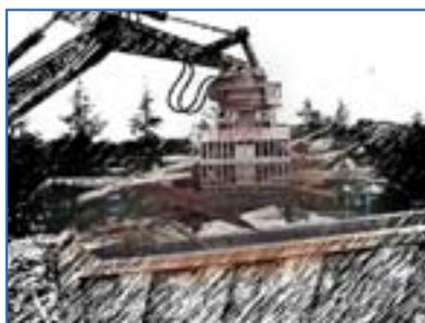
Fig 23: Limpieza del solar: retirada de escombros pétreo y residuos de madera.
