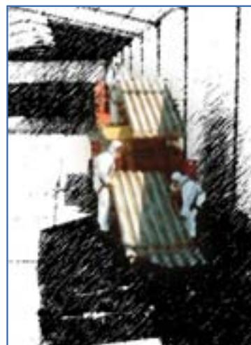
Fig. 13. Retirada de placas de fibrocemento.
