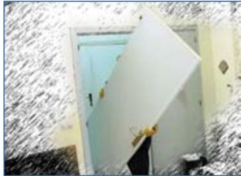
Fig 19: Desmontaje de elementos de carpintería de madera (marcos, puertas, etc.).
