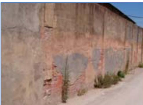
Fig 4: Edificio industrial de cerramiento de ladrillo y revoco de mortero.
