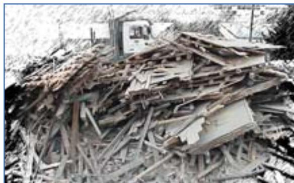
Fig 22: Demolición mecánica de la estructura con recuperación de elementos de madera estructural.
