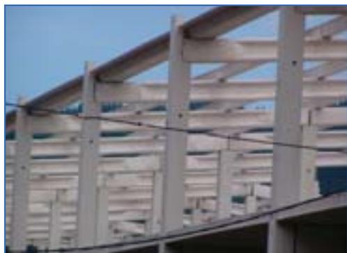
Fig 3: Edificio industrial de estructura de hormigón prefabricado.
