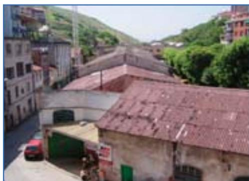
Fig 5: Edificio industrial con cubierta de fibrocemento.
